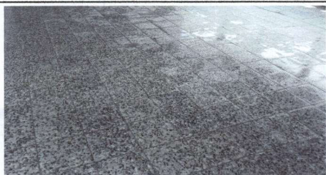
Foto 3: Finalización de sustitución de piso de torta por piso granito.
