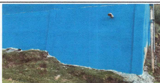
Foto 6: Finalización de reparación de muro perimetral.
