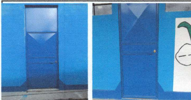
Foto1: Finalización de reparación de puertas e instalación de chapas.
