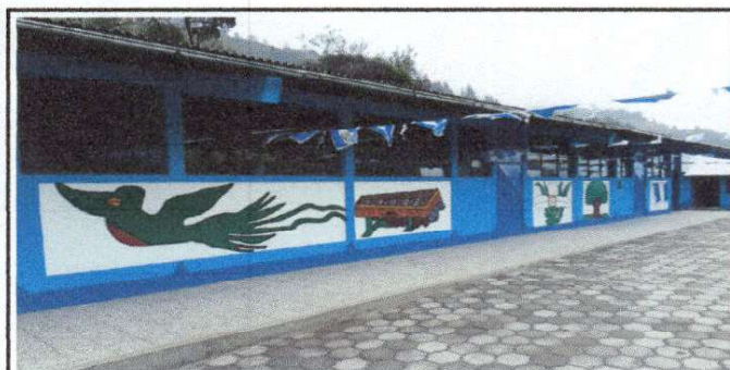
Foto 5: Finalización de pintura en exteriores.
